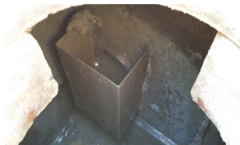
Dispositif aval permettant de mettre en charge la canalisation
